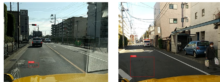
図① MCRで検出、日報に記載なしの例
