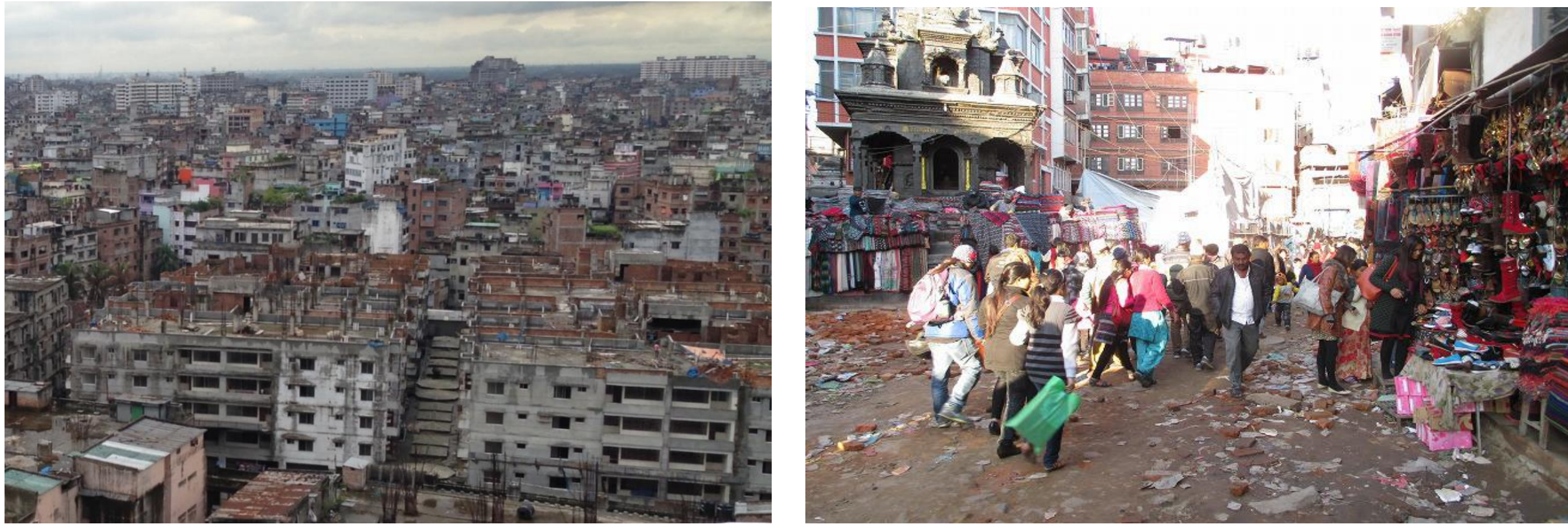
地震対策のための建物状況把握 舗装状況改善のためのIRI値の浸透
